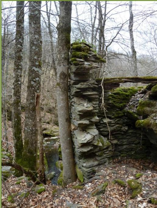
Le mur prend appui sur un arbre qui a poussé ici, la structure est construite en pierre sèche.
