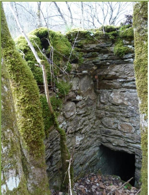
Coin Nord-Ouest de l'intérieur de la gourgue, l'ouverture en bas permet l'arrivée de l'eau au niveau du moulin.
